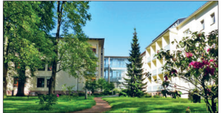
Außenansicht der neuen vollstationären Pflegeeinrichtung vom Park aus Foto: © LMK
