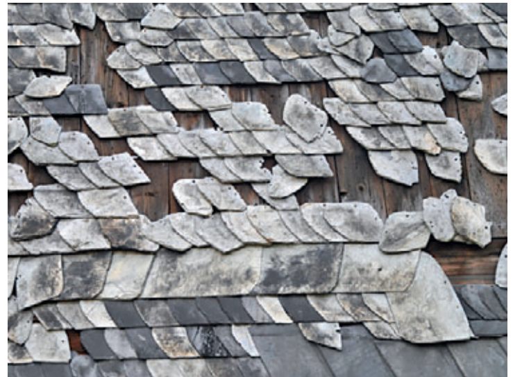
Eher rosteten die Nägel durch, als daß der Schiefer kaputtging
