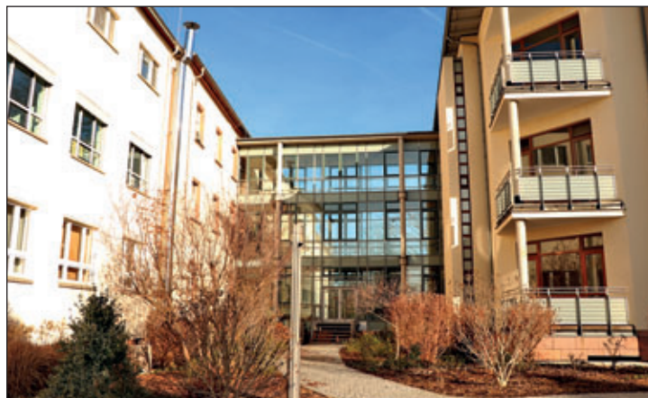
Foto: (v.l.n.r.) Gebäudekomplex Altbau, Zwischenbau und Bettenhaus. Im freigezogenen Bettenhaus haben die Sanierungs- und Umbaumaßnahmen bereits begonnen.
