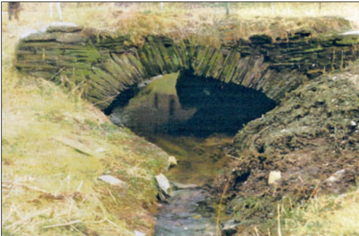
Schieferbrücke über den Leitebach
