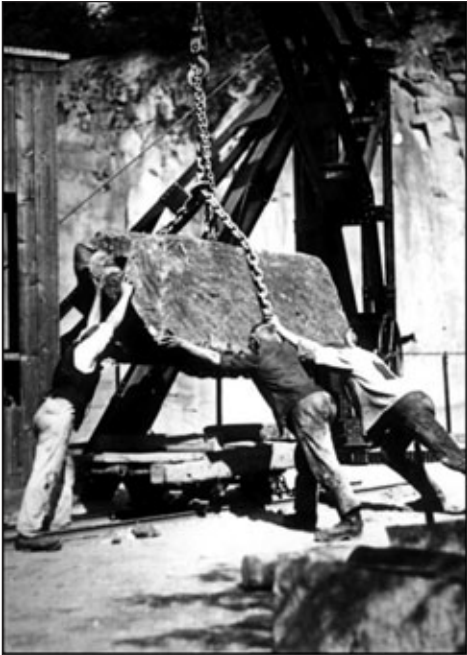
Steintransport mit Hebetechnik und schienengeführten Wagen
