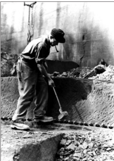
Abtrennen von Steinblöcken
