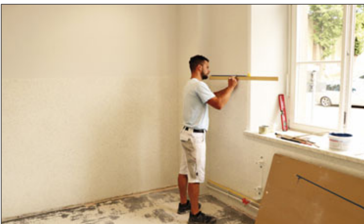
Mit den Malerarbeiten in der Oberschule „An der Mulde“ wurde die Fa. Elke Ibisch aus Arras beauftragt. Im Foto: Daniel Adler bei Abschlussarbeiten an der Sockelkante.
