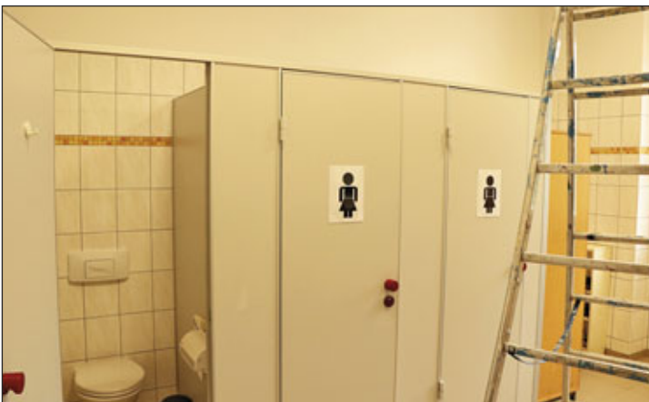
In der Regenbogen-Grundschule sind über die Ferien Toiletten und zugehörige Waschräume auf allen 3 Etagen malermäßig instandgesetzt worden.
