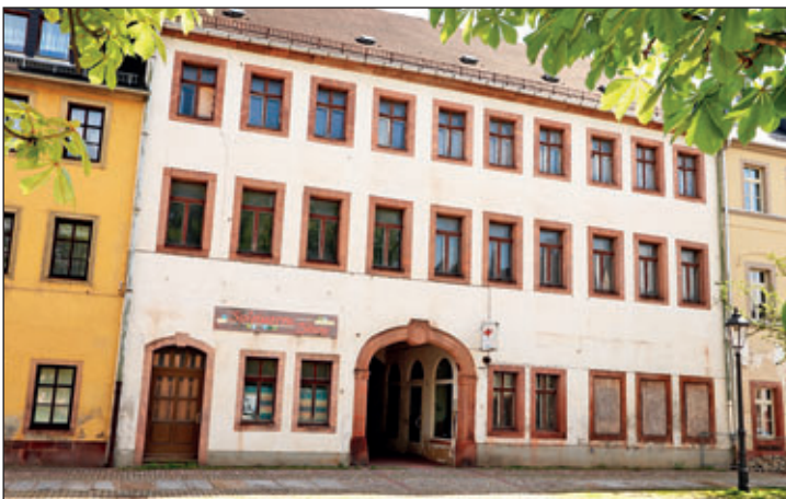
Vorderhaus Topfmarkt 9 Hier beginnen die Bauarbeiten im 4. Quartal.
