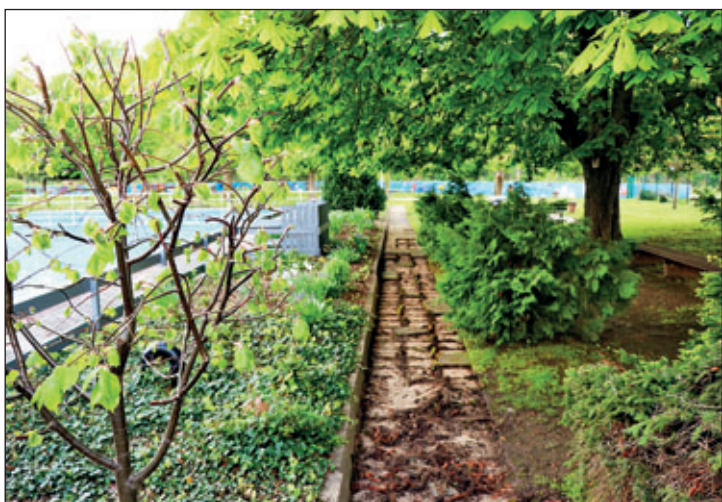
Sanierung der Zuwegung vom Nichtschwimmer- zum Schwimmerbecken
