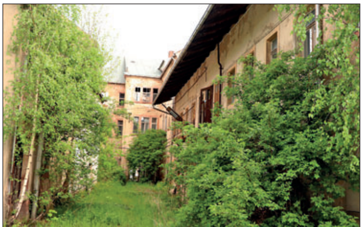
rückwärtiger Bereich – künftiger Standort für 3 Reihenhäuser
