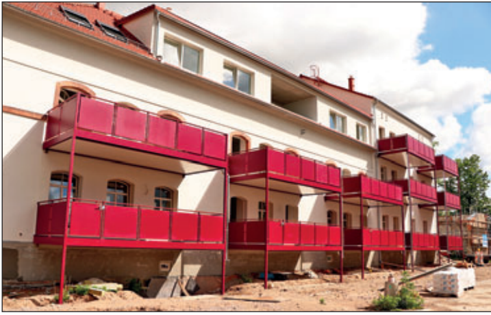
Saniertes und modernisiertes ehemaliges Brauereigebäude Foto: Südfassade
