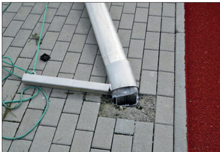
Von Sturmböen abgeknickter Fanggittermast.
