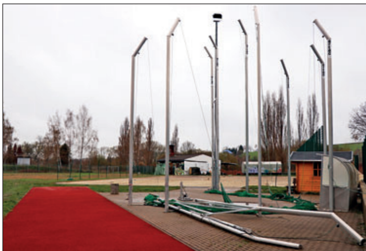
Defekte Speer- und Diskuswurfanlage im Vater-Jahn-Stadion. In Kürze soll für rund 14.000 Euro die Instandsetzung erfolgen.
