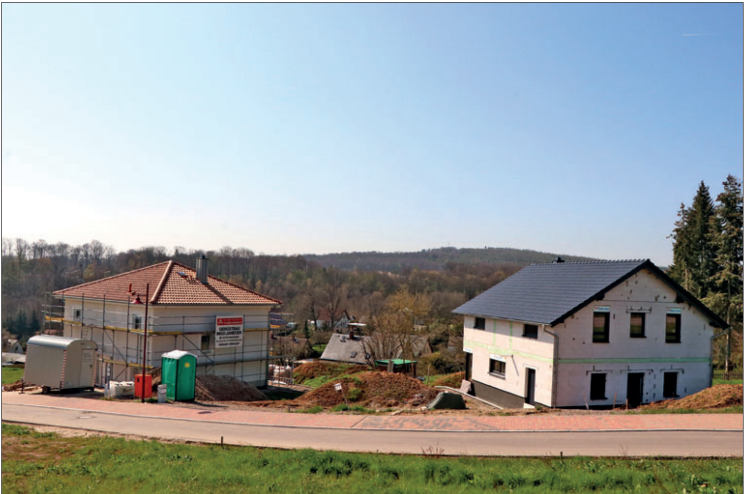
Baugrundstücke ausverkauft – das neu erschlossene Wohngebiet „Am Weinberg“ ist voll. Wie Oberbürgermeister Frank Dehne informierte, wurden 18 Grundstücke verkauft, die restlichen drei sind von Bauwilligen reserviert. Foto: Jörg Richter
