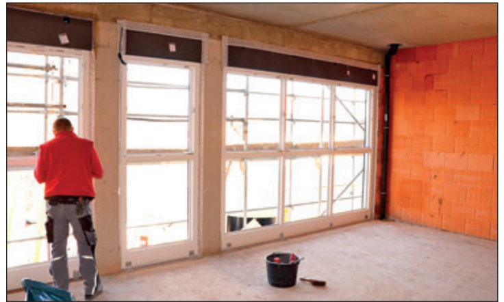
Der Einbau von Fenstern in den Gruppenräumen ist inzwischen abgeschlossen.
