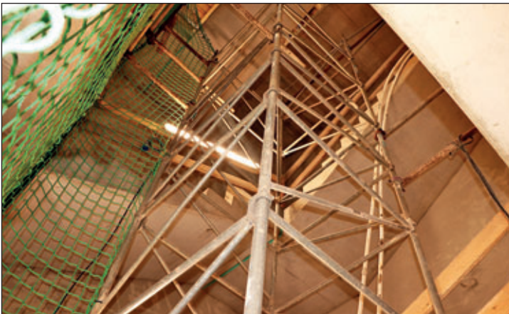
Treppenhaus – hier wird in Kürze ein Aufzugsschacht mit Fahrstuhl installiert.
