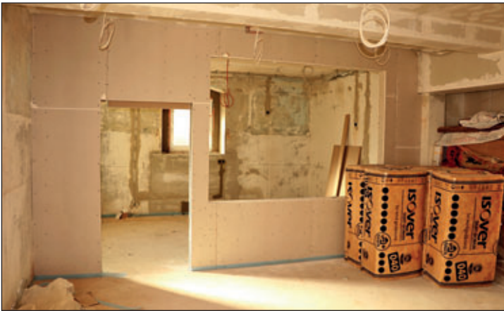
Bauliche Ertüchtigung für die Speisenausgabe im Multifunktionsraum Erdgeschoss
