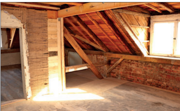
Der Dachgeschossausbau erfolgt spartanisch, hier ist keine öffentliche Nutzung vorgesehen.
