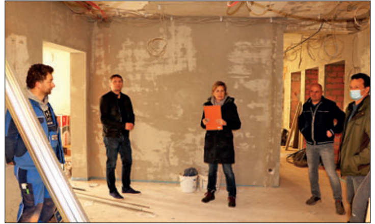
Bauingenieurin Simone Pfeifer (M.) und Oberbürgermeister Frank Dehne (2.v.li.) im Gespräch mit Bauauftragnehmern verschiedener Gewerke.
