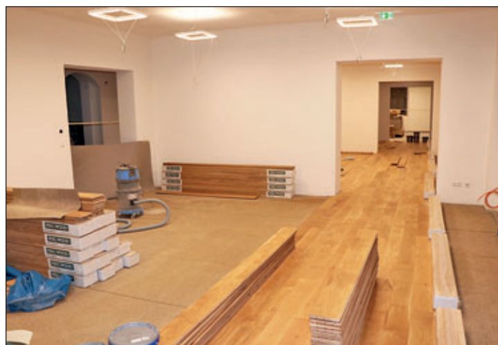
Im Erdgeschoss sind die Fußbodenverlegearbeiten in vollem Gange. Wenn alles fertiggestellt ist, werden die Besucher auf Eiche-Massivholzdielen durch die Räume wandeln.
