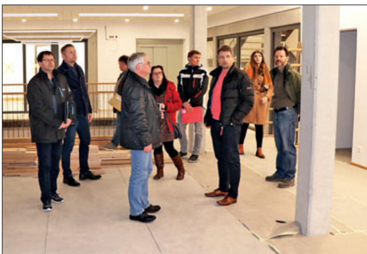
Die Mitglieder des Sozialausschusses der Stadt Rochlitz beim Rundgang durch das bauseitig fast fertiggestellte Büchereigebäude „Alte Lateinschule“ am Kunigundenplatz. Die Neueröffnung der Stadtbibliothek ist für Juni geplant.
