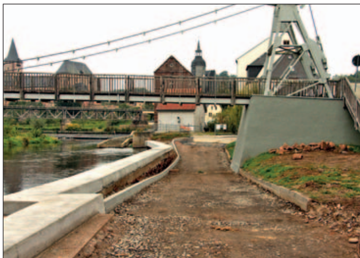
Großbaustelle Muldeinsel – von der Fa. Wolff aus Milkau werden folgende Sanierungsarbeiten ausgeführt: Deckensanierung Fahrschulplatz, Sanierung der Fahrbahn auf 150m ab Brücke (Foto) sowie eine partielle Reparatur der Ufermauern im Bereich der Hängebrücke.
