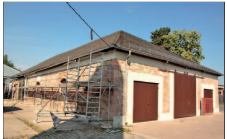
Fassadensanierung am Nebengebäude des VfA Rochlitzer Berg in der Schützenstraße Fotos: Jörg Richter
