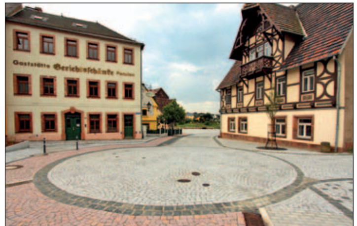
Wieder eine Top-Adresse – saniertes Mühlplatz
