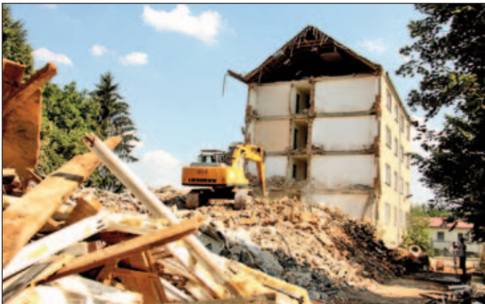
Abriss Wohnheim Poppitzer Straße
