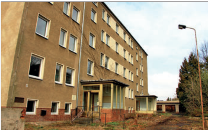
Rückbau des ehemaligen Wohnheims in der Poppitzer Straße rückt näher – der Besitzübergang vom Landkreis auf die Stadt erfolgte am 01.03.2017.
