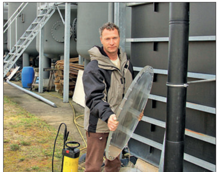
Jan Kugler bei Vorbereitungsarbeiten zum Reinigen des Schlammwasserbehälters
